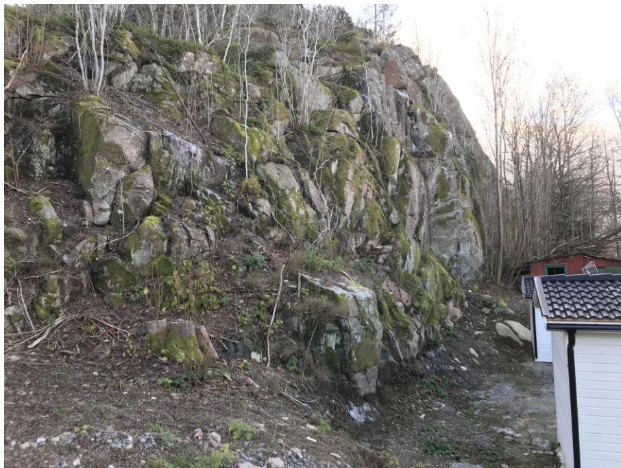
Figur 3.3. Bergväggen bakom befintligt bostadshus med ekonomibygnader, bild tagen mot söder. Inga uppenbart lösa block eller skivor syns i slänten men vegetationen som växer i sprickorna kommer på sikt att spräcka ut block/skivor. Även viss isbildning kan skönjas mitt i slänten.
