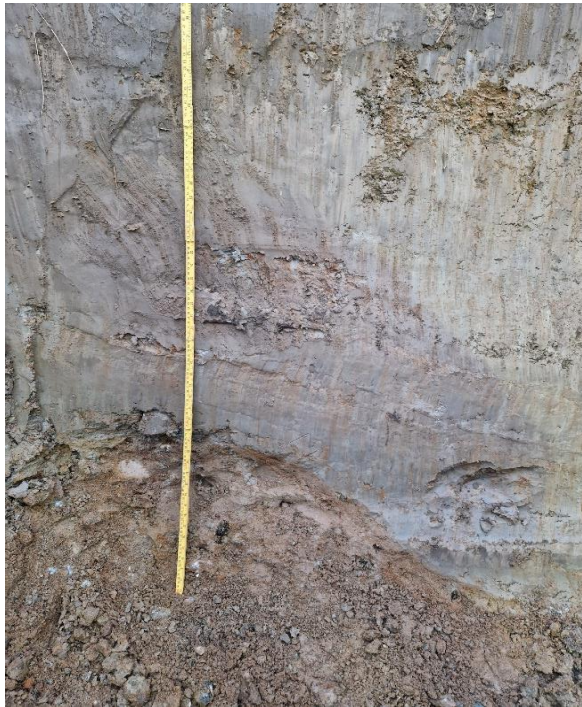
Figur 6b. Provgrop 2302 (ca 0,5-1,0 m djup) med varierande gräns mellan siltig lera och underliggande sandlager med innehåll av sten och block.
