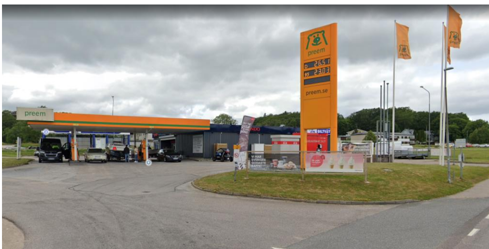
Figur 1 Foto över drivmedelsstationen på fastigheten Ström 1:46, Lilla Edet [4].
