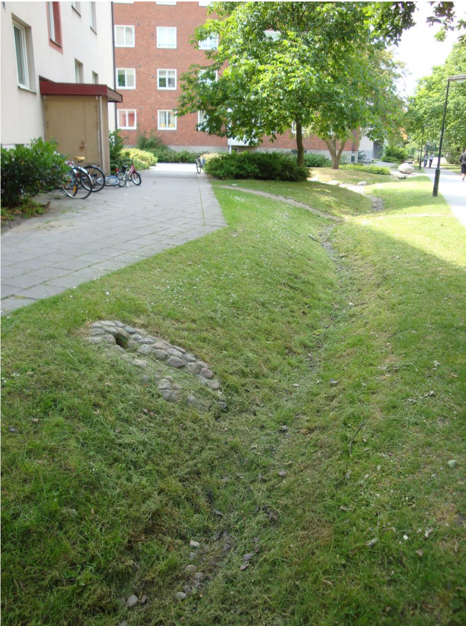
Figur 17. Exempel på utformning av ett avskärande dike.
