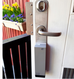
Bild 3 - nyckelgömma monterad på ytterdörr.
